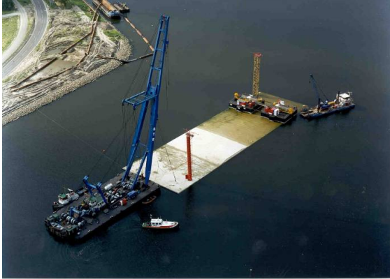
Fig. 14 Floating shearleg and pontoons (Wijkertunnel)
